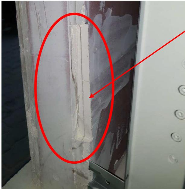
Beispiel eines Lochs für eine Bandhalterung in einer Gipskartonwand.
